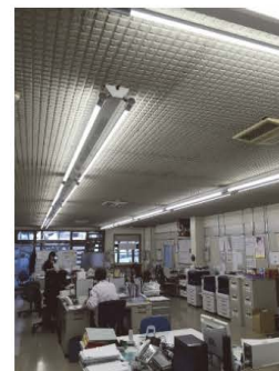
▲事務所内のLED照明
