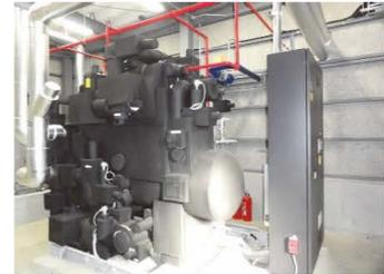
▲高効率水冷式自然冷媒冷凍機
