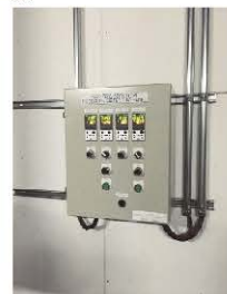
▲冷凍機電子圧力制御盤
