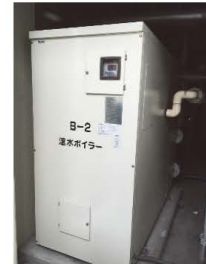
▲都市ガスボイラー
