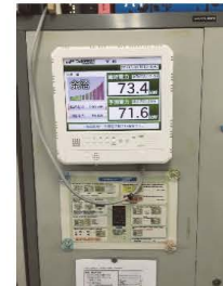
▲デマンド監視装置
