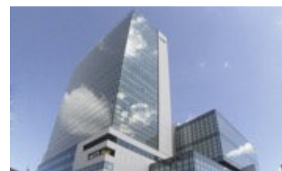
▲ビル全体でDHC方式空調を導入
