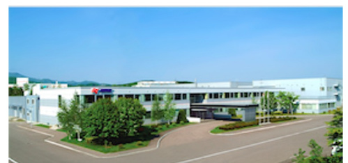
▲生産工場は24時間体制で稼働
