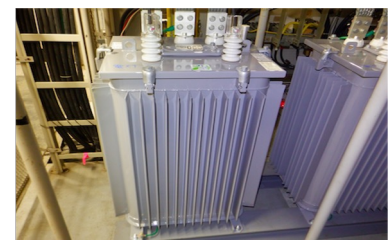
▲超高効率変圧器に更新
