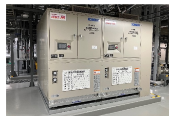
▲隣接のエネルギーセンター棟に設置したヒートポンプ
