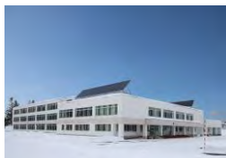
美深中学校(太陽光パネル)
