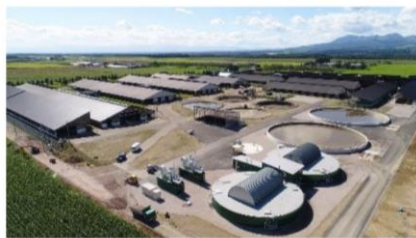
バイオガスプラント
