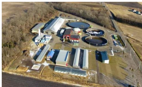
中鹿追バイオガスプラント
