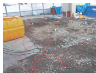
※バイオインジェクション工法 パイプを打ち込み、バイオ製剤を注入する浄化法
