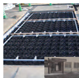
北海道工業試験場玄関前の施工過程
