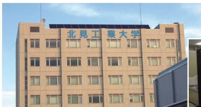
太陽光発電設備
