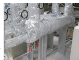
シェル&チューブ式熱交換器
