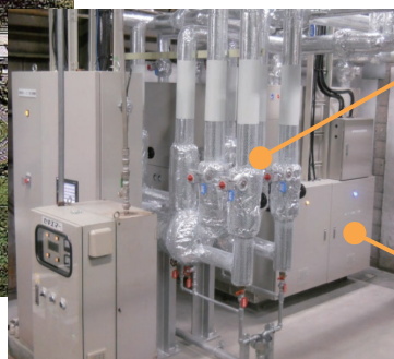
シェル&チューブ式熱交換器
