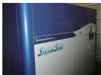
小型蒸気発電機
