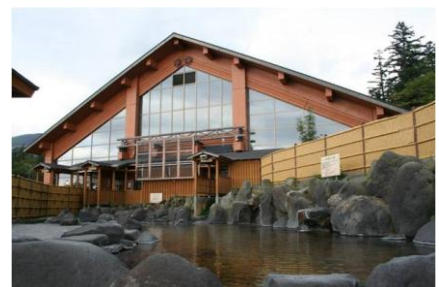
「どさんこ・ポート」第一号クレジット案件、上富良野町「吹上温泉保養センター 白銀荘」
