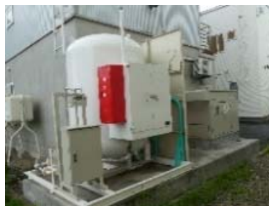
災害用ＬＰガスバルク貯槽と非常用ＬＰガス発電機
