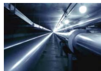
熱供給の導管（カルバート内部） ((株)エナジーソリューション)
