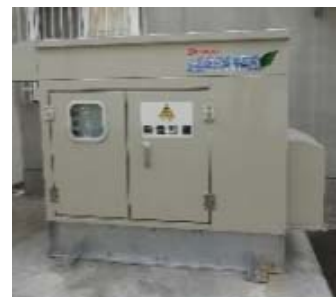
災害用ＬＰガスバルク貯槽と非常用ＬＰガス発電機
