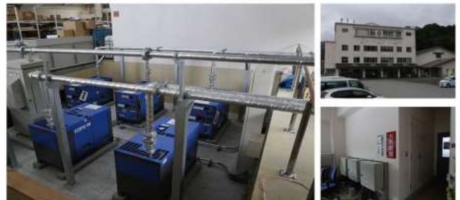
岩手県 大槌町役場様 灯油式非常用発電機 (8.5KVA×5台=42.5KVA 屋内4階設置)
