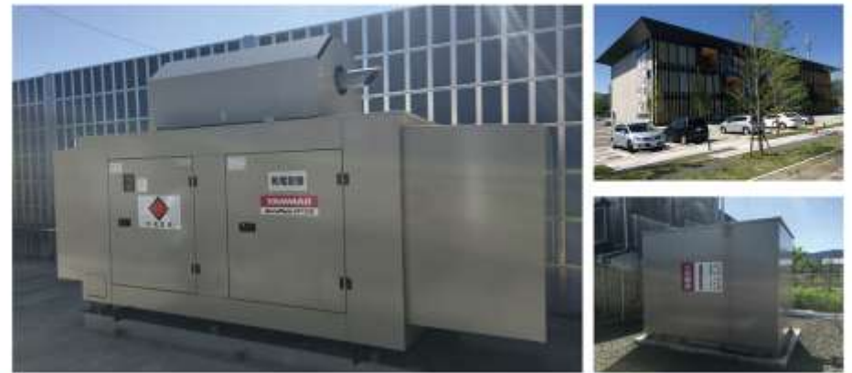
福島県 国見町役場様 A重油式非常用発電機 (130KVA 屋外設置)
