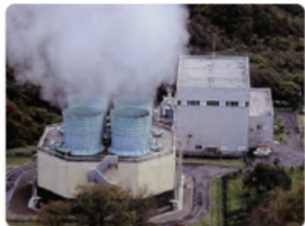
北海道電力(株)森地熱発電所 (地熱) (2.5万kW)
