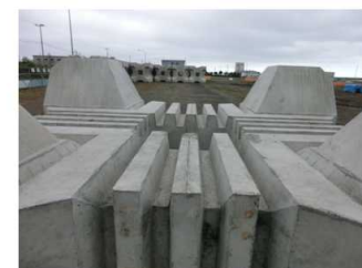
ウニ、ナマコが生息・移動出来るように溝を配置。溝の配置に至っては、専門家の知見を取り入れた。
