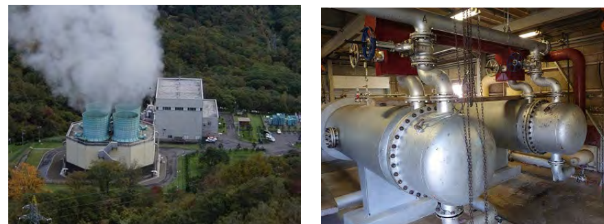
森地熱発電所（左）と地熱利用熱交換施設（右）
