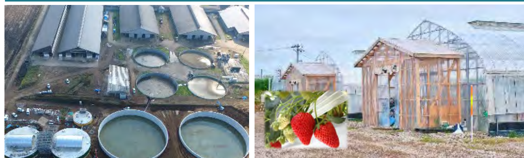
畜産バイオガス発電 (町内エネルギー自給率100%)
