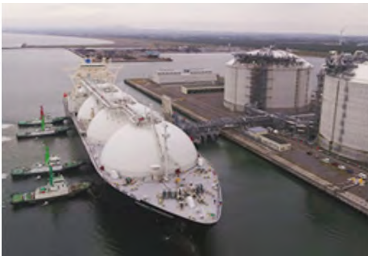
石狩LNG基地
