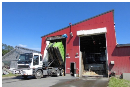
鹿追町バイオガスプラント
