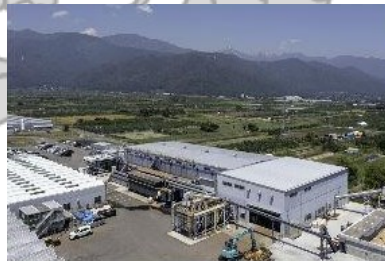
長野県： 木質バイオマスを用いた トリジェネレーションの運営
