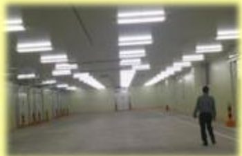
▲倉庫内LED照明
