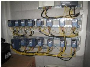
ポンプのインバーター制御装置
