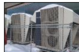
空気熱源ヒートポンプチラー
