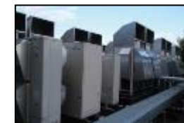
空水冷熱源ヒートポンプ
