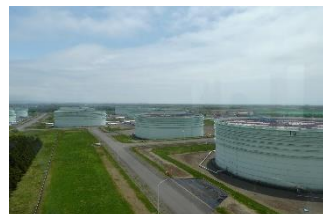
敷地内には57基もの備蓄タンクがある
