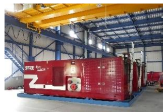
大容量泡放水砲システム 1分間で6万リットル放水ができる
