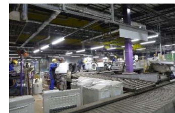
洗濯機の解体作業の様子
