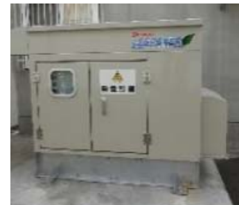
災害用 LP ガスバルク貯槽と非常用 LP ガス発電機
