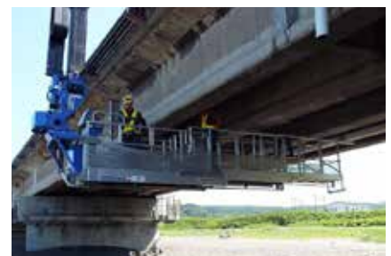
コンクリート構造の橋梁の検査
