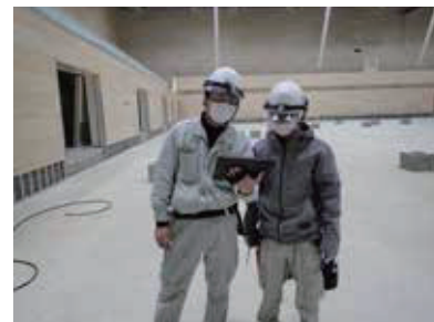
現場でのデジタルツールの活用
