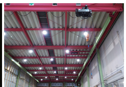
天井照明のLED化
