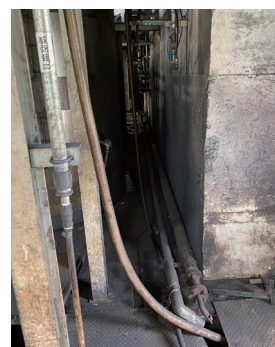
ドレントラップシートリーク 補修箇所
