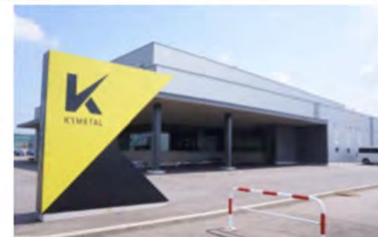
2021年竣工の新工場
