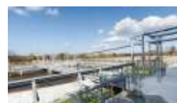
汚水浄化処理施設
