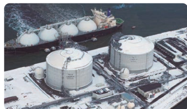
北海道ガス(株) 石狩LNG基地
