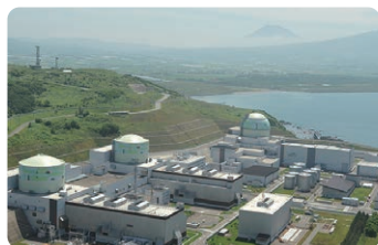
北海道電力(株) 泊発電所(原子力)
