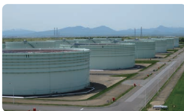
苫東石油備蓄(株) 国家石油備蓄基地
