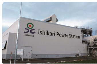
北海道ガス(株)北ガス石狩発電所 (天然ガス(LNG))
