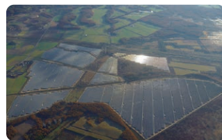
苫東安平ソーラーパーク(株) テラスエナジー苫東安平ソーラーパーク
