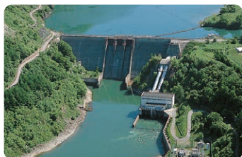
北海道電力(株) 静内発電所(水力)
