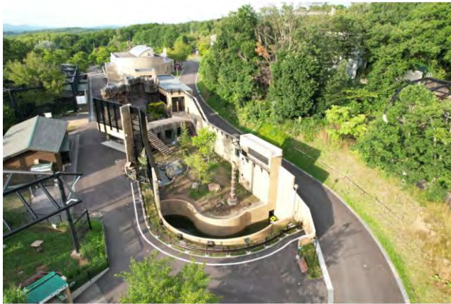
施工例（動物園施設）
