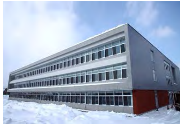
施工例（小学校）
