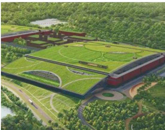
<次世代半導体工場>
